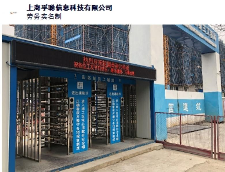
劳务实名制一卡通，是通过为施工现场工作人员发放非接触式智能卡，依托智能卡对现场人员进行精细化管理，精确掌握人员考勤、各工种上岗情况、安全专项教育落实、违规操作、工资发放、洗浴用水、食宿管理等情况，实现对施工现场人员各方位管理。
